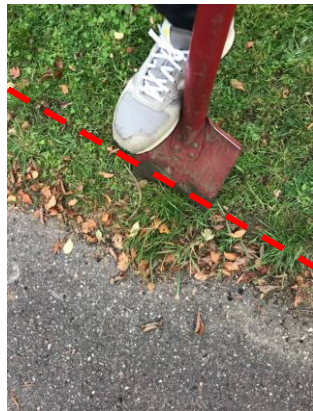
1. Start med at grave ca. 10 cm fra der, hvor du formoder asfalten ender.
